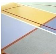
PU Sportbeläge sind fugenlose, mehrschichtige, punktelastische und unifarbene Bodenbeläge mit einer Polyurethan (PU) Spachtelmasse als Oberschicht.
