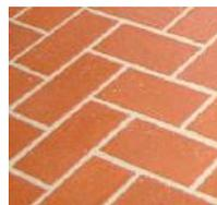
Keramische Bodenbeläge sind heterogene Erzeugnisse aus Ton und Zuschlagstoffen wie Feld- oder Flusspat.
