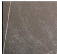
**La plupart des mortiers à joints sont sensibles aux acides. Bien mouiller les joints avant d'utiliser des nettoyants acides.**
